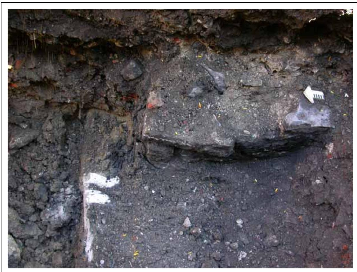
**Figure 33 : Vue vers l'est des vestiges d'une fondation de pierre calcaire posée sur une dalle de béton dans la tranchée MTL07-25-12-1T30 localisée dans le talus situé à l'est de l'autoroute Bonaventure, entre les rues Ottawa et Wellington.**
