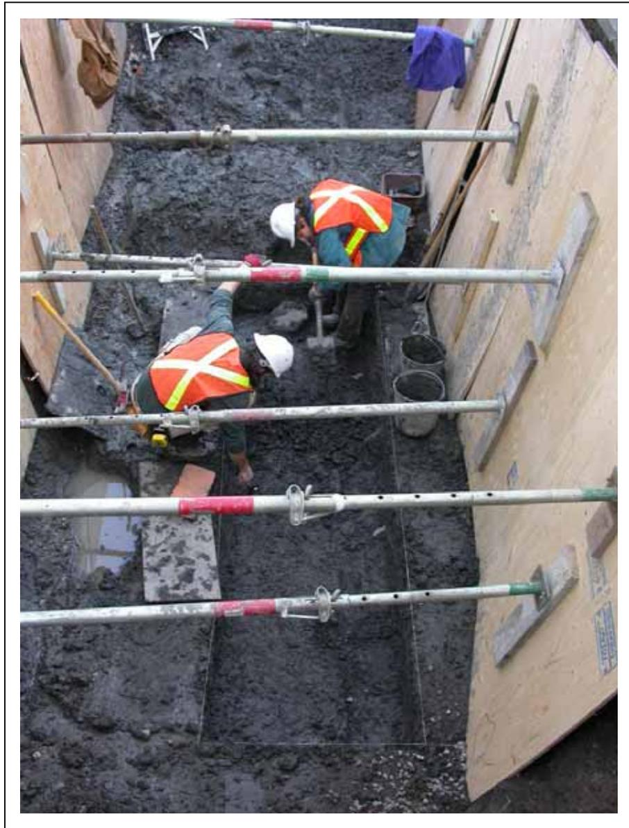
**Figure 23 :** Vue en plongée vers le sud de la tranchée MTL07-25-12-1A. L'étalement des parois latérales et les infiltrations d'eau ont compliqué la fouille. (Photographie numérique BiFj-57-07-N1-70)
