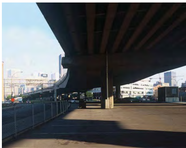
Vue vers le nord de la structure élevée de l'autoroute, à l'intersection des rues Brennan et Nazareth.
