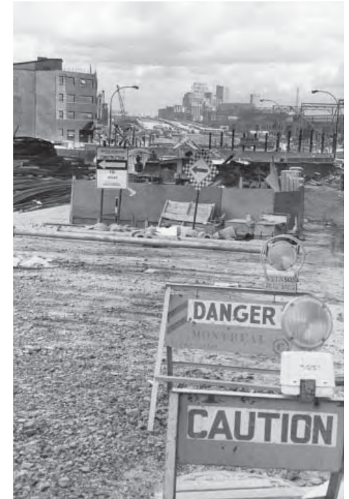
Vue vers le Sud des travaux de construction de l'autoroute Bonaventure.
