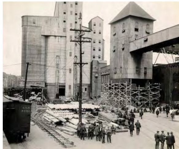
Le silo no 1 en 1915. Archives du Port de Montréal.
