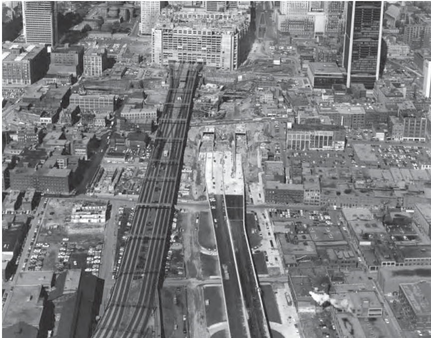
Vue aérienne de la construction de l'autoroute Bonaventure, des accès à l'autoroute Ville-Marie et de la Place Bonaventure, en 1966. Ville de Montréal. Gestion de documents et archives.
