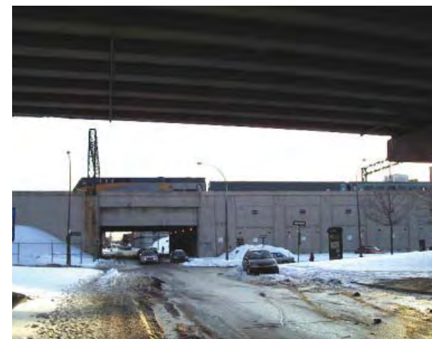
Le passage sous les structures, au niveau de la rue
