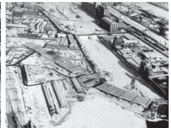
Construction de la traversée du bassin Peel et du passage au-dessus de la rue Brennan. Archives La Presse.
