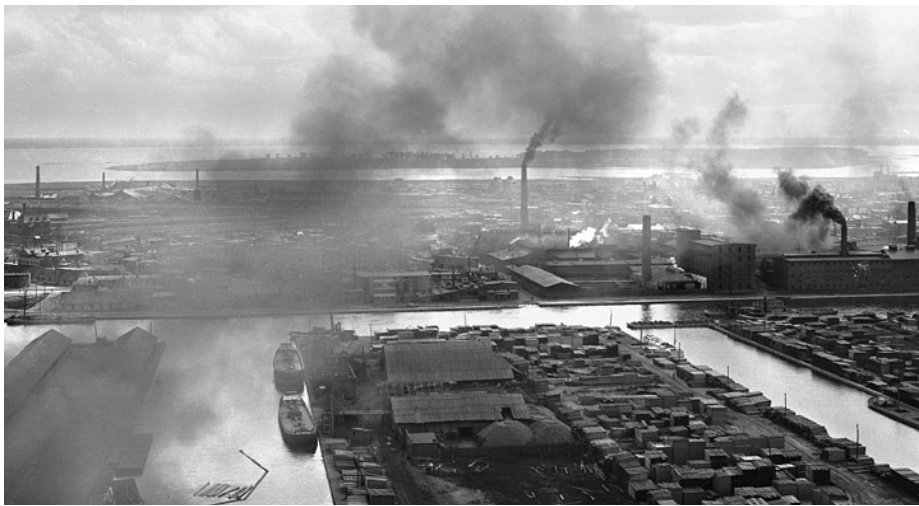
L'industrialisation aux abords du canal de Lachine, vue depuis la cheminée de la centrale de la Montreal Street Railway, en 1896.
