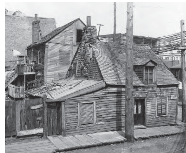
Maison ouvrière en piteux état et dépourvue de cour. Musée McCord.
