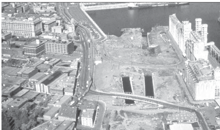
L'entrée du canal de Lachine remblayée, au niveau du pont de la rue Mill.
