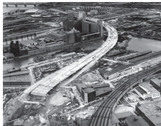
Construction de la traversée du bassin Peel en 1966. Archives La Presse.
