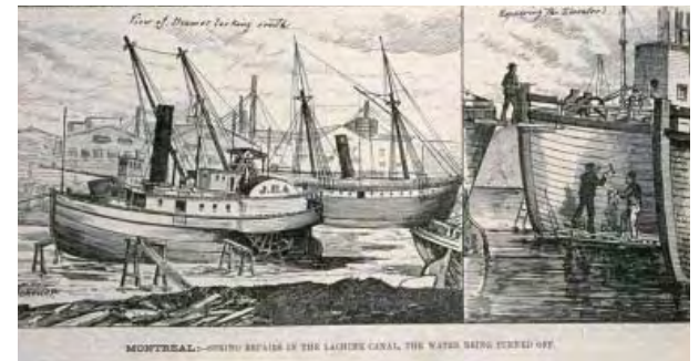
Réparation de bateaux au canal de Lachine, en 1876. Bibliothèque et Archives nationales du Québec.
