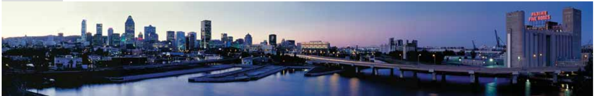
Vue de nuit du bassin Peel et de l'autoroute Bonaventure à partir du silo de la Cereal Foods Canada. en 2003
