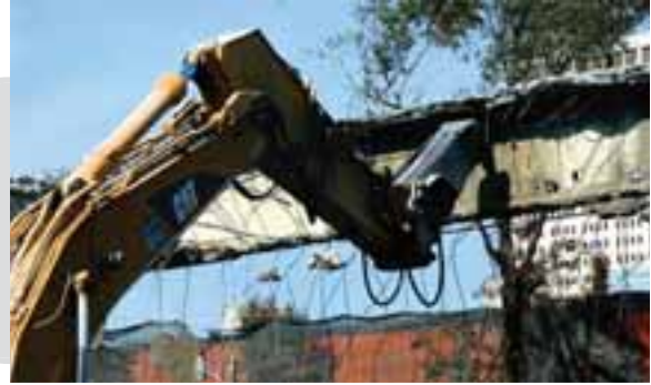
La démolition de l'autoroute Octavia Central à San Francisco en 2003
