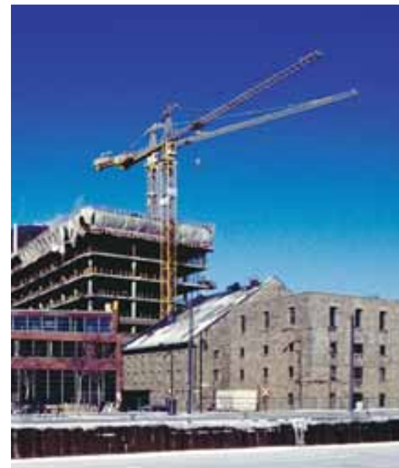
Cité Multimédia, phase 8 en construction en bordure du canal de Lachine en 2002
