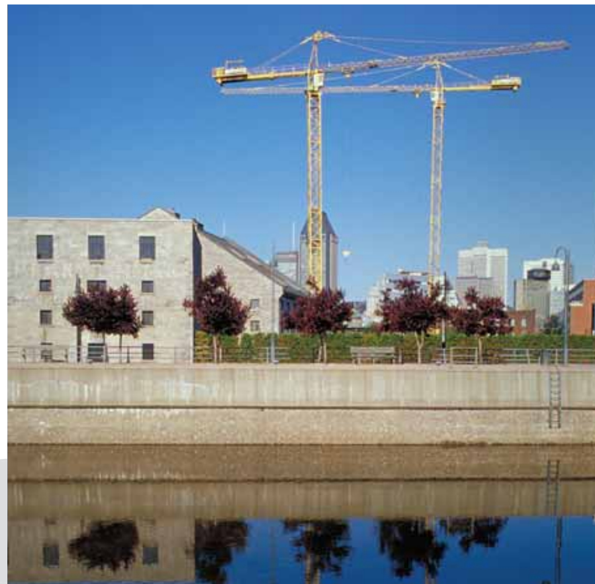
La Cité Multimédia, phase 8 en construction en bordure du canal de Lachine en 2002
