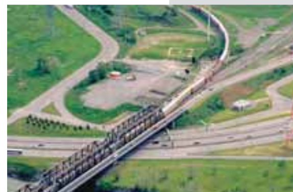
Le passage inférieur sous les voies ferrées du CN représente un défi important
