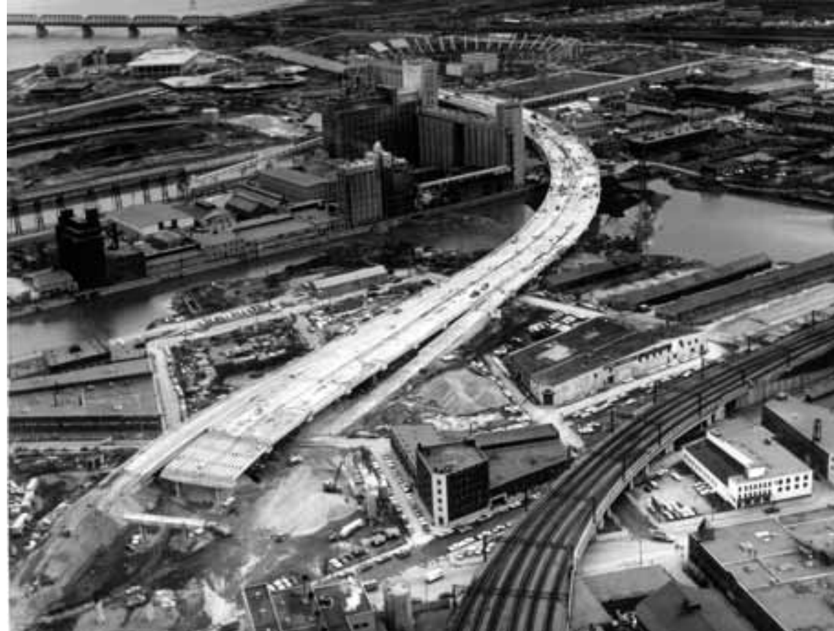
Construction de la traversée du bassin Peel en 1966
