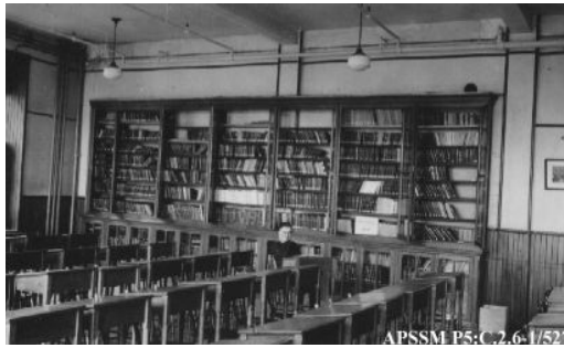
À gauche : Salle de cours du Séminaire de philosophie APSSM P5:C.2.6-1/527
