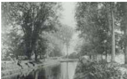
Photo du bassin du Grand Séminaire par Henderson, vers 1880, A McCord
