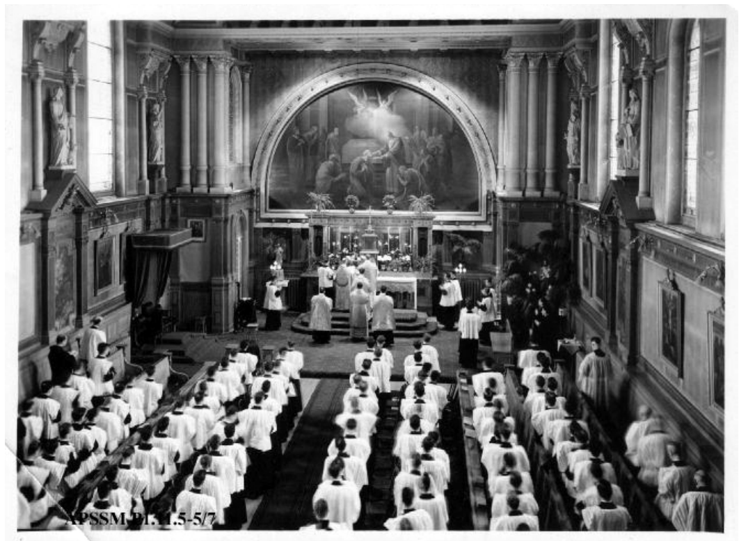
Chapelle du Séminaire de philosophie après les travaux des années 1940, APSSM P5:C.2.5-5/7
