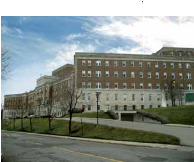
ENTRÉE DU GARAGE DE STATIONNEMENT CÔTÉ OUEST (VUE DU BOUL. MONT-ROYAL)
