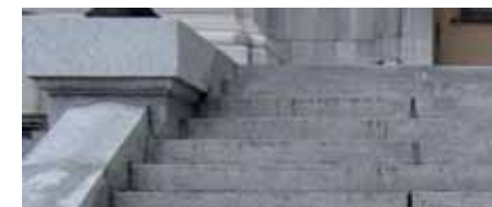
Figure 62 - Exemple de matériau noble : pierre naturelle
