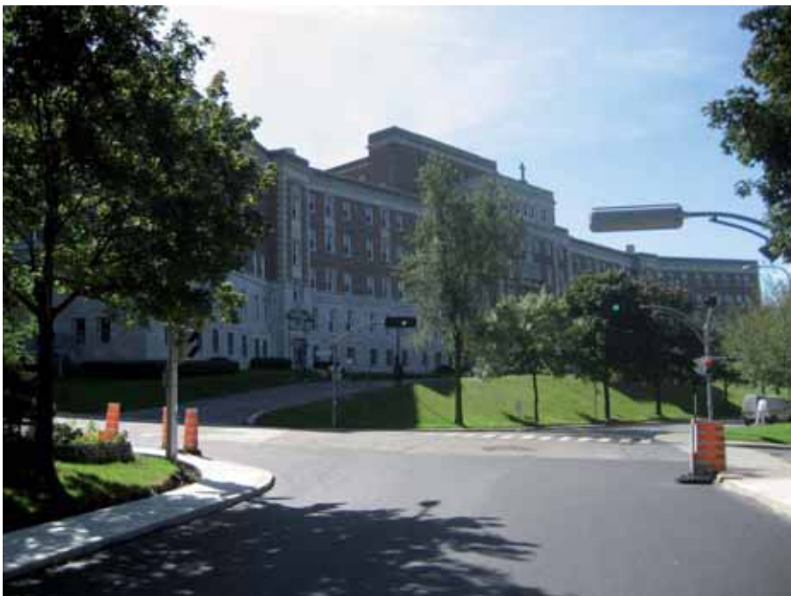
Figure 78 - Vue depuis la rue Maplewood existant (A)
