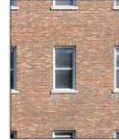
OUVERTURE PONCTUELLE POUR CHAQUE TRAME STRUCTURALE
