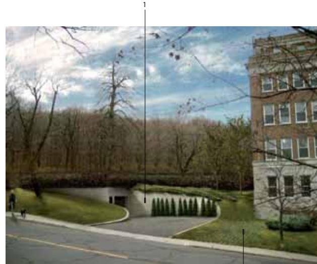
ENTRÉE DU GARAGE DE STATIONNEMENT CÔTÉ EST (VUE DU BOUL. MONT-ROYAL)
