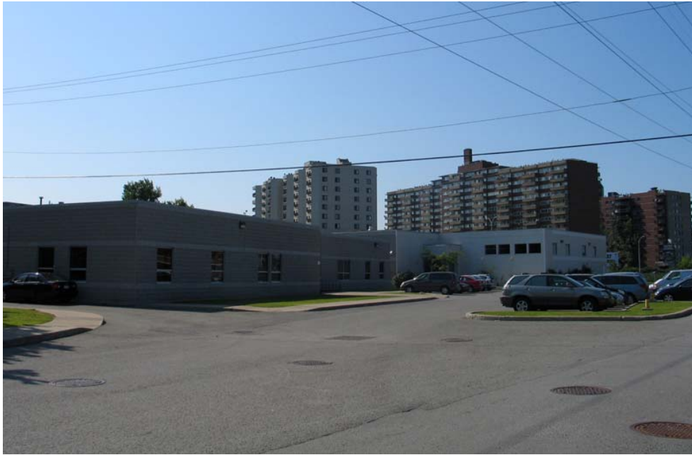
Photo 2 - Édifices de faible hauteur à l'est du site du projet
