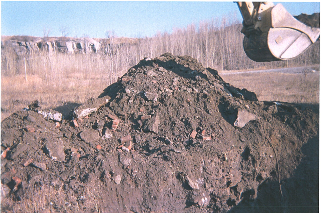
PHOTO N° 6 Remblai contenant environ 65% de débris (TR-15)
