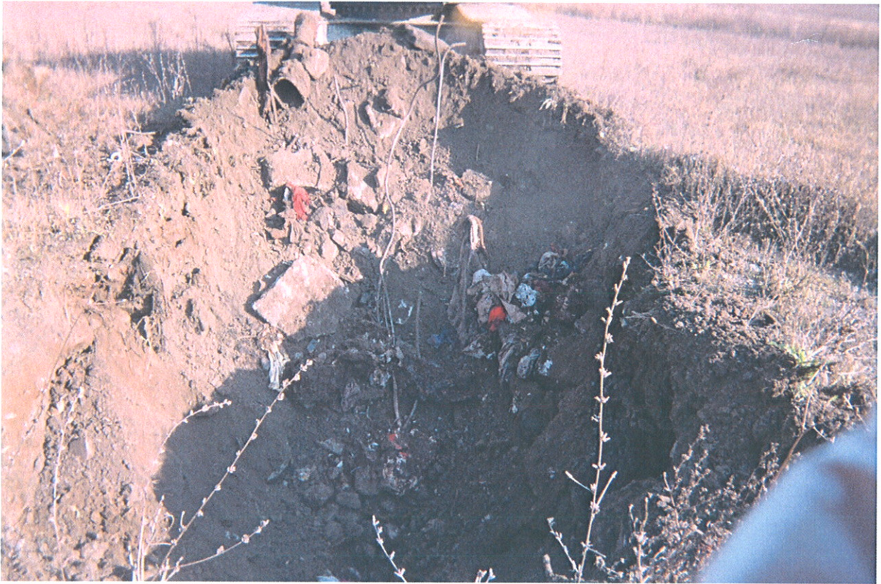
PHOTO N° 5 Remblai contenant environ 60% de débris (TR-13)
