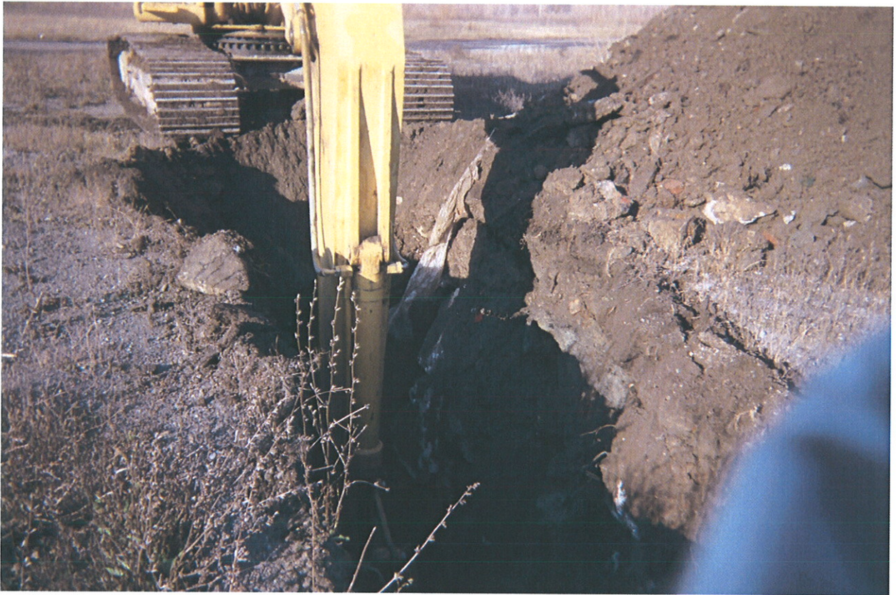
PHOTO N° 3 Remblai contenant environ 40% de débris (TR-9)
