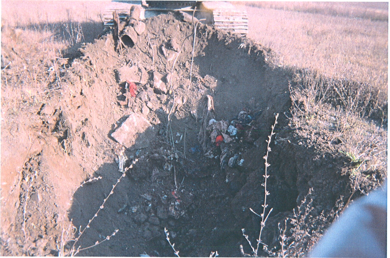
PHOTO N° 5 Remblai contenant environ 60% de débris (TR-13)
