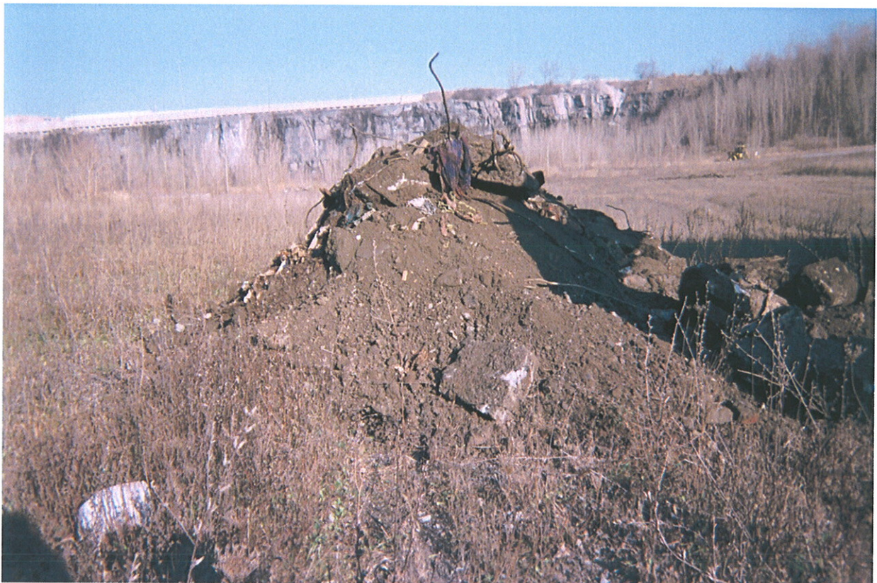
PHOTO N° 4 Remblai contenant environ 50% de débris (TR-12)
