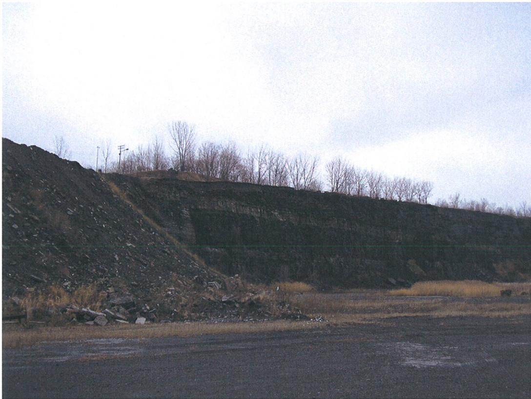
PHOTO N° 11 Paroi nord-est (plateau 3)
