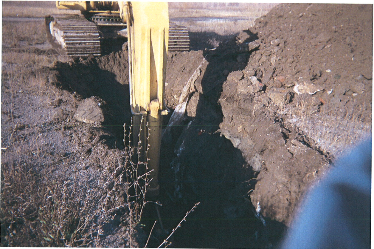
PHOTO N° 3 Remblai contenant environ 40% de débris (TR-9)
