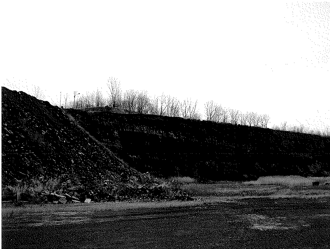
PHOTO N° 11 Paroi nord-est (plateau 3)
