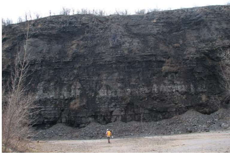
Photo 1 : Présence d'accumulation de roches issues de l'érosion constante des parois rocheuses.
