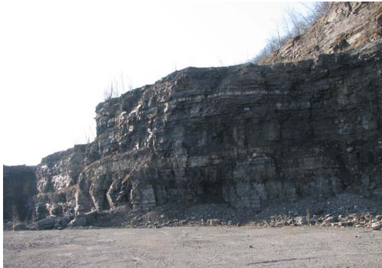
Photo 2 : Parois rocheuses instables.
