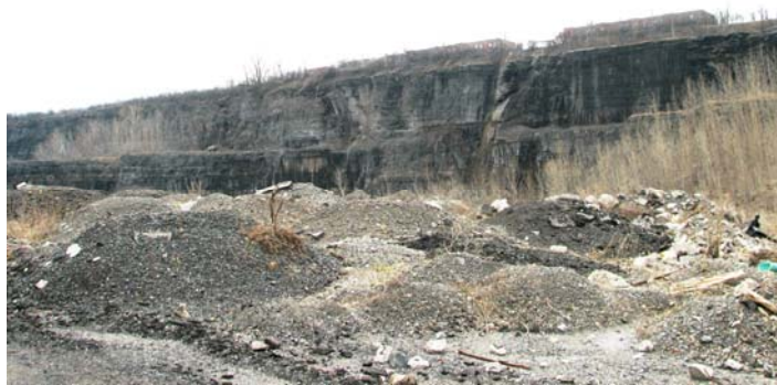
Photo 4 : Présence de failles propices au décrochement.
