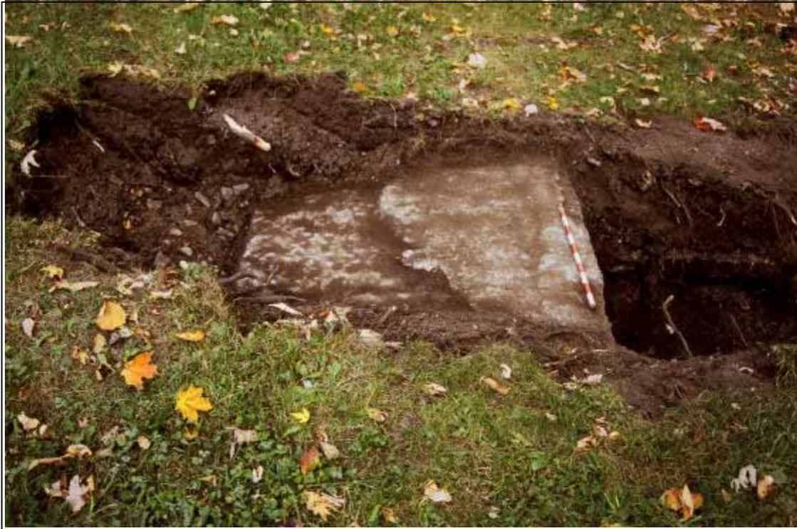
Photo 7 : Sommet du mur ouest de l'ancien réservoir en partie recouvert d'un crépi localisé à quelques centimètres sous la surface (MTL04-25-15-D1-16)
