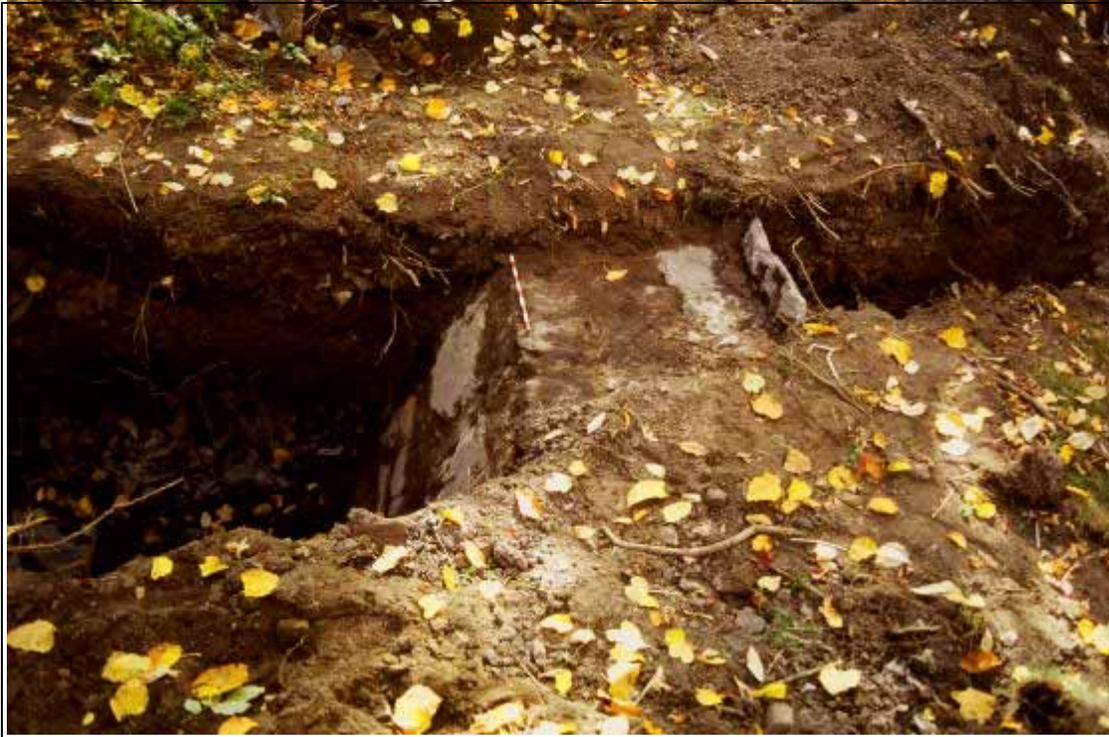
Photo 9 : Grandes dalles de grès vert sur le parement intérieur (côté gauche de la photo) du mur est de l'ancien réservoir (MTL04-25-15-D1-7)
