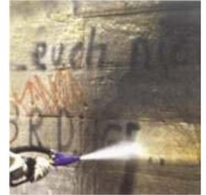
Le jet de sable, de bicarbonate de soude (soda ou «petite vache»), ou le jet d'eau à haute pression peuvent être utilisés sur la **brique, le béton, les blocs de ciment, le stucco et la pierre.**
