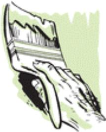
Si le graffiti est d'une couleur foncée, il est recommandé d'utiliser un scellant comme sous-couche afin qu'il ne ressorte pas au travers de la nouvelle peinture.
