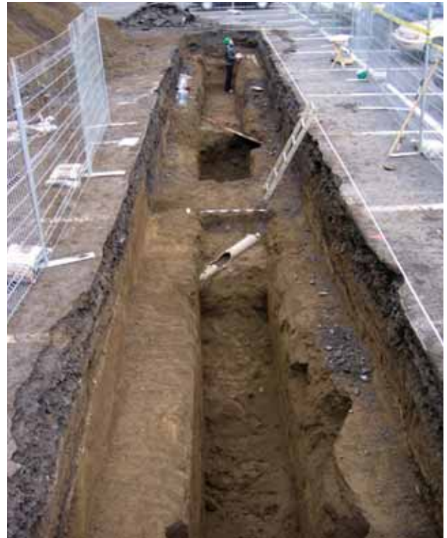
Photo 1 - Vue d'ensemble de la tranchée 54A – Vue vers le nord (BjFj-56-2006-N1-31)
