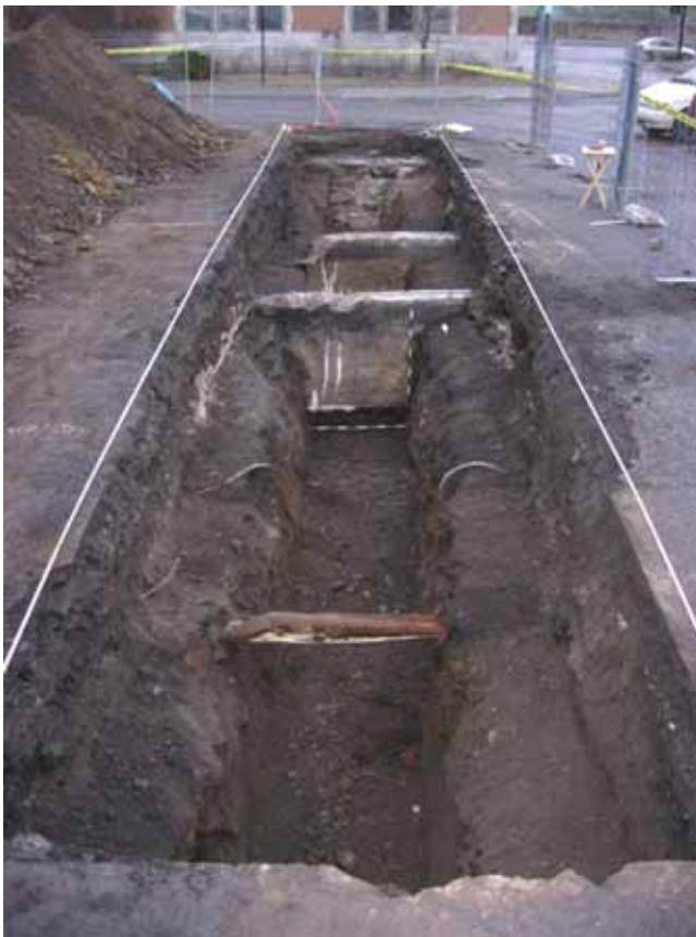
Photo 5 - Vue d'ensemble de la tranchée 54C – Vue vers le nord (BjFj-56-2006-N1-47)
