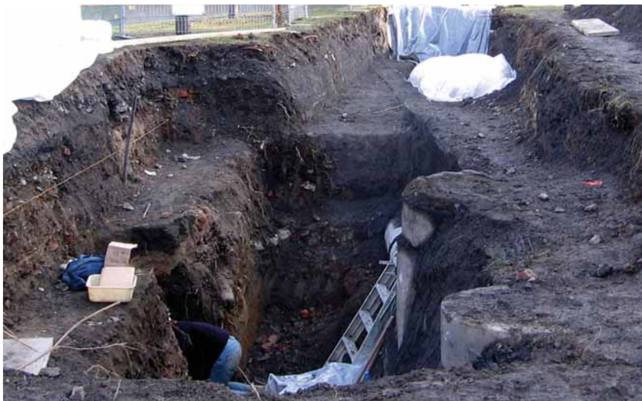
Photo 7 - Vue d'ensemble de la tranchée 54D. Le cliché illustre bien l'axe des services d'utilités publiques mis au jour en cours d'excavation – Vue vers le sud (BjFj-56-2006-N3-12)
