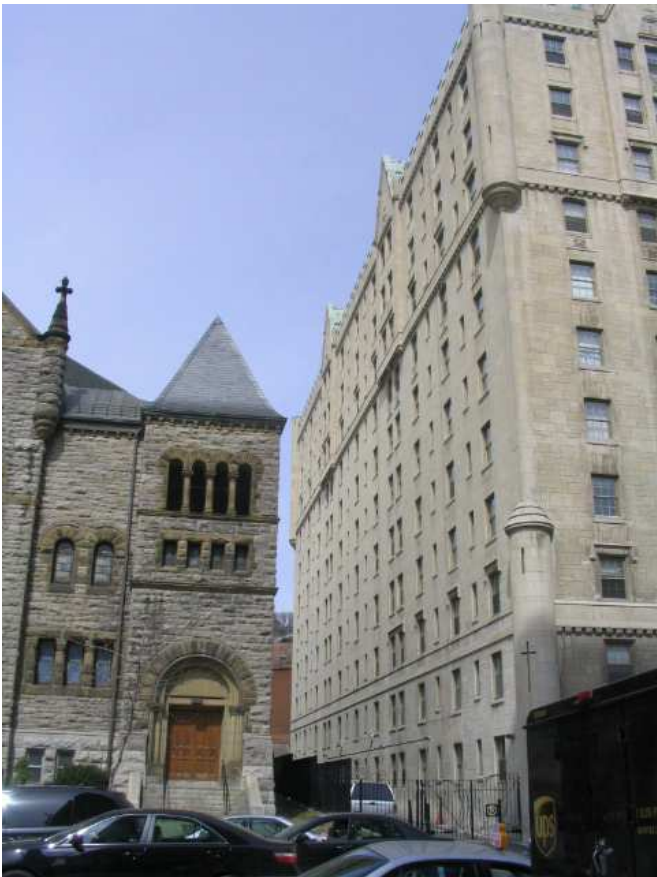
Façade des Appartements Le Château adjacente à l'église Erskine & American
