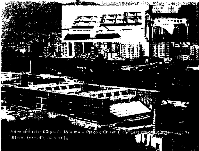
Fig. 8 Vue en plongée du chantier de l'Université scientifique de Palerme
