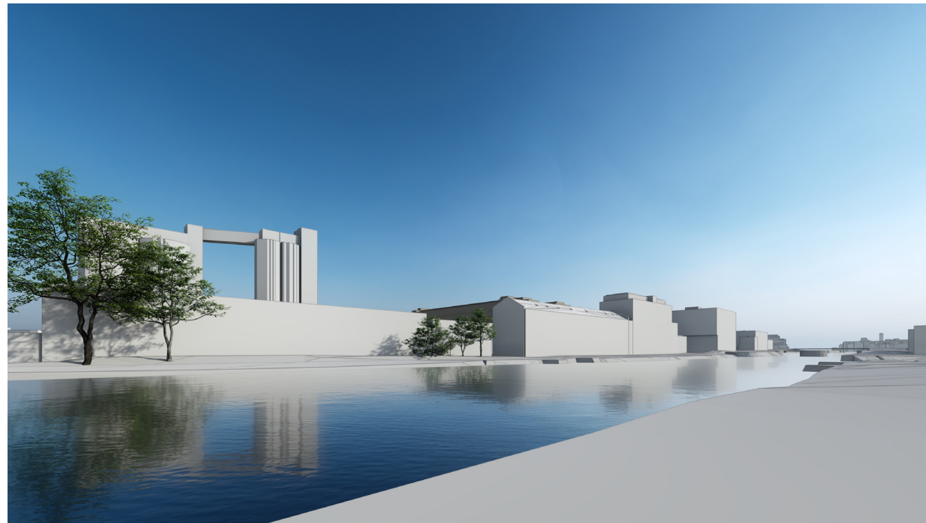
Vue vers le Nordelec depuis le canal Lachine (existant)
